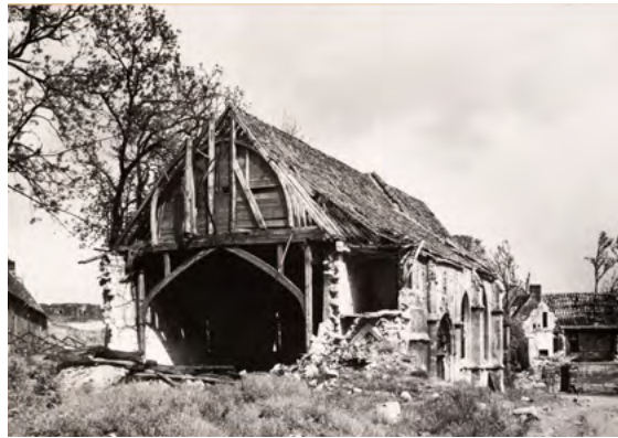
Charles Hurault, Fiche d'inventaire de la Commission des Monuments historiques, Église Saint-Georges, charpente, 1945. © Ministère de la Culture (France), Médiathèque du patrimoine et de la photographie, diffusion GrandPalaisRmn Photo
