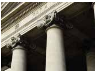
Détail du portique de la façade du palais des juridictions (dit « Palais de Justice »). Photo É. Faisant.
