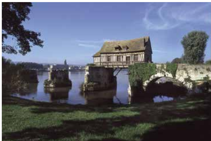
5 Vieux moulin de Vernon (Eure), le « Moulin des ravageurs » du film Les Mystères de Paris d'André Hunebelle, 1962. Région Normandie – Inventaire général / Christophe Kollmann
