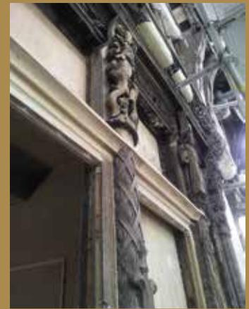
Restauration en cours et pose de nouvelles traverses respectant le profil ancien ; au premier plan, un poteau de 1886 mal restitué ; au second plan, un poteau ancien ayant conservé l'extrémité du listel passant.
