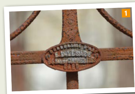
1 Détail d'une clôture en fer, signée du serrurier d'art caennais Lesage, installé 34 rue des Carmélites.
