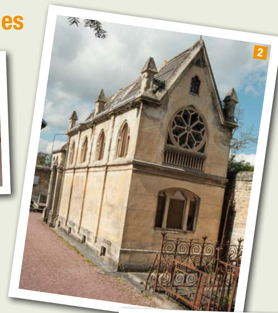
2 Chapelle néo-gothique monumentale construite par l'entreprise Jacquier pour la famille de La Ville vers 1878. Elle est située près de l'accès piéton au nord-ouest du cimetière.
