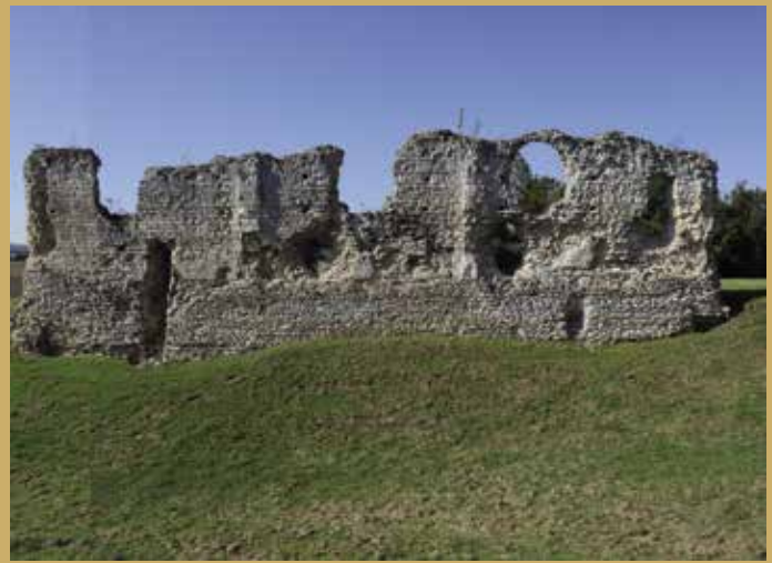
Mur conservé du logis du Vieux château de Vatteville
